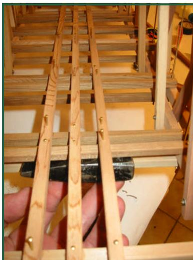
schließlich werden die Fahrbahnträger befestigt. Unbedingt unter die Leiste etwas gegenhalten, z.B.: einen anderen Hammer, um ein Durchbrechen der Stangen zu vermeiden, es schwingt dann auch nichts beim Festnageln. Die Stangen wurden vor dem Nageln vorgebohrt, um ein Sprengen der Leisten zu vermeiden. Den Abstand der Leisten wurde mit einer Rolle Isolierband, das ergibt 1,5cm, festgelegt.
