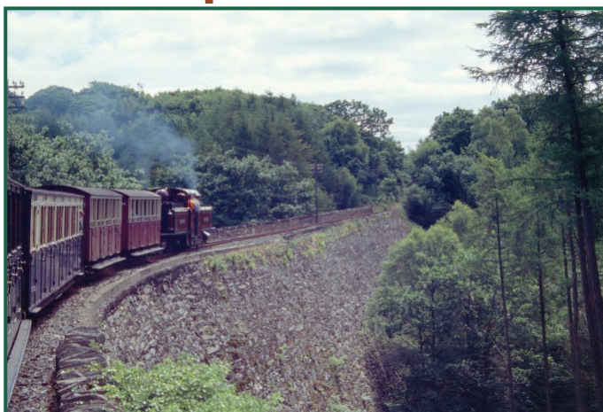
Der Zug quert den mit 62 Fuß (ca. 20 m) hohen steinernen Damm "Ceï Mawr", den höchsten auf der Strecke.
